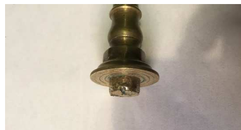
Particolare del tubo di collegamento troncato
